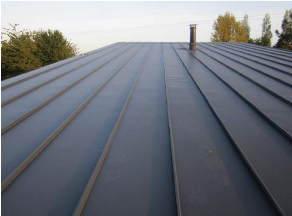
Couverture zinc Prépatiné quartz pose à joint debout
